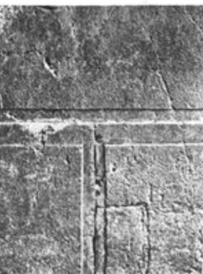
סותות השוליים באבני החומה אינו אחיד; הוא רחב יותר בחלקו העליון מאשר בזה התחתון, וזאת כדי "לפצות" על הדגש לו זוכה החלק התחתון, כתוצאה מהצל הנופל עליו. מאותה סיבה הסתוות בצד השמאלי רחב יותר מהימני.
