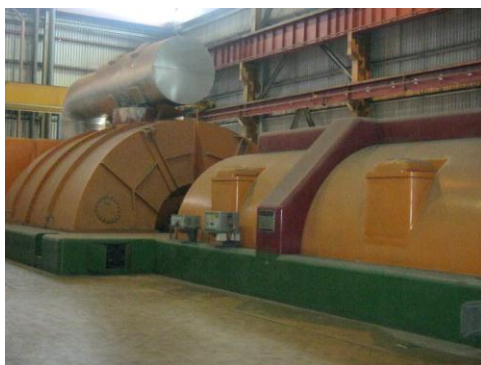
ח. אחת המורבינות. הלחץ הקיטורי מסובב את פרופלור המורבינה במהירות הגורמת לשדה מגנטי המיצר חשמל.
