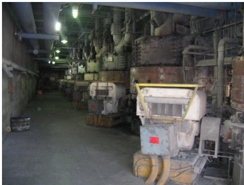
ו. שורת מטחנות המוחנים את אבני הפחם לאבקה המשמשת כחומר בעירה עבור מי הדודים.
