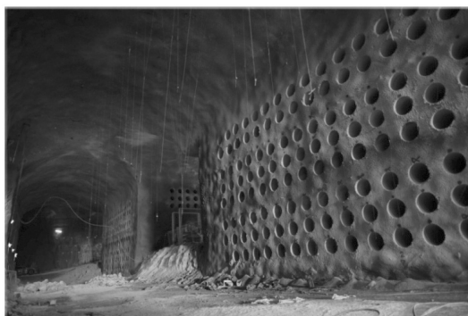
תמונה מס' 2: כוכין עגולים החצובים בקירות המנהרה [וכפה"נ מצופים בשיכבת בטון]
