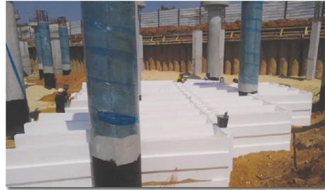
תמונה 1: תבניות קלקר עבור קבורת מכפלה-זוגית
