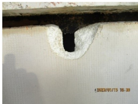
תמונה 9: סתימת פתח הכוך ג"כ מקלקר [בד"כ הוא שלם, רק כאן הוא נשבר מעט]
