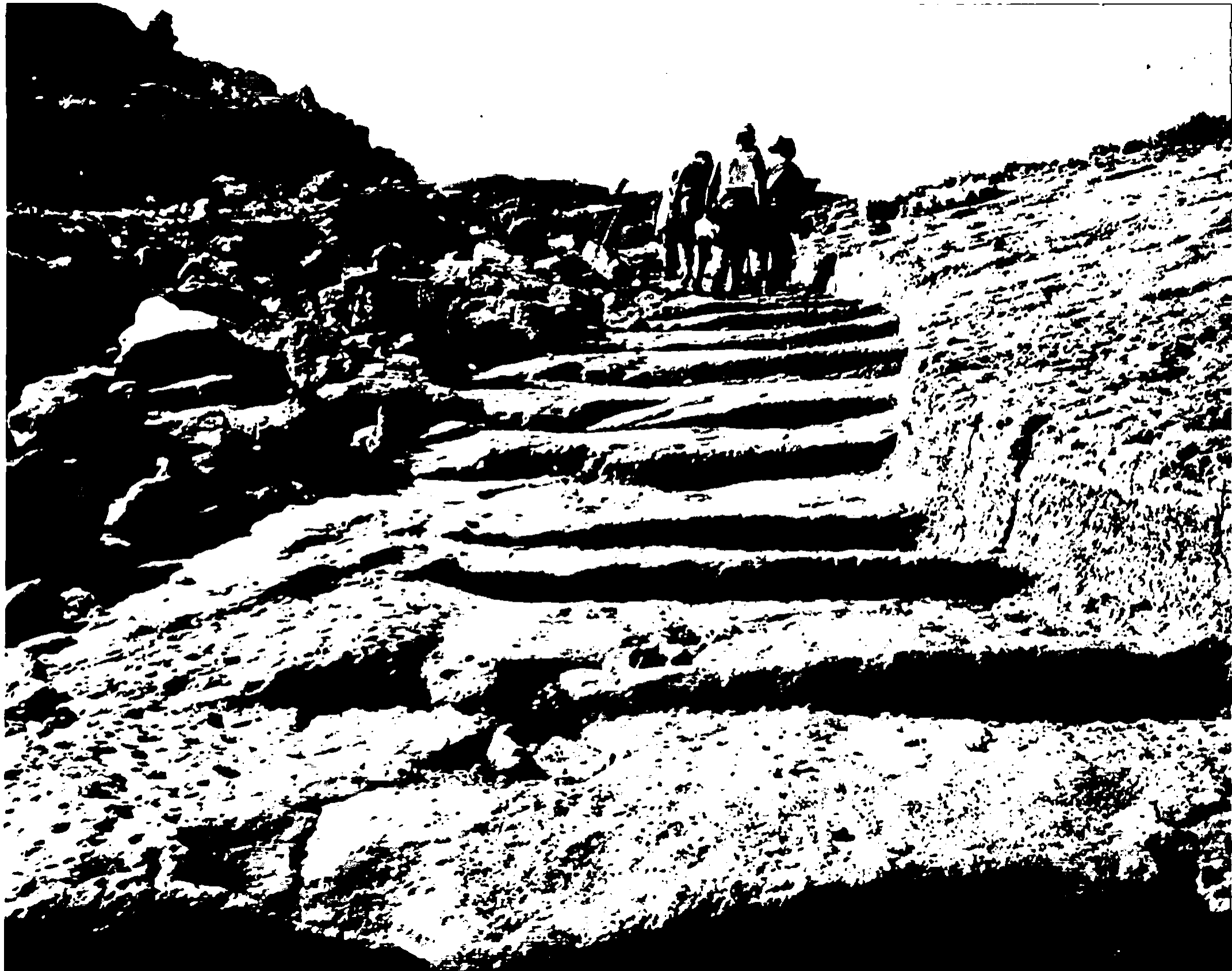
ממפעלי הרומאים: דרך רומית במעלה עקרבים בנגב. הרומאים חצבו לעתים מדרגות בסלע כדי להקל על העלייה והירידה בו.
